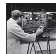
1947年スウェーデンの科学者により、光波による測距システムが発明されました。1953年には世界初の光波測距儀「Geodidimeter Model1」が発売されました。その後、1970年代にはトータルステーションとして進化を遂げ、1980年代には精密サーボ駆動の自動視準・自動追尾機能トータルステーションが登場しました。そして、Trimbleは60年以上の歴史を誇るGeodimeterの「測距技術」と「サーボモーター制御技術」の全てを継承し、更なる進化を遂げたTrimble S8シリーズが登場しました。
